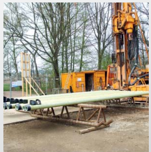
Solebohrung Bad Elster
