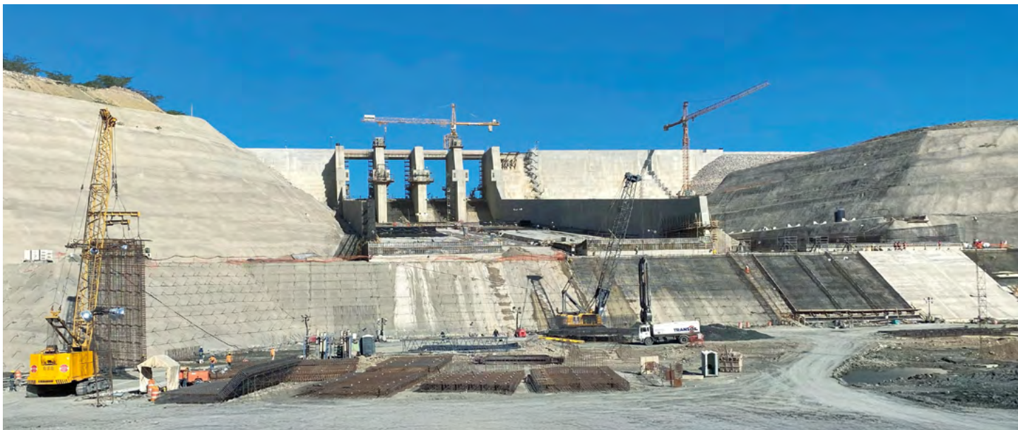
Damm-Projekt in der Karibik: Bauer stellte u. a. 26.000 m 2 Dichtwand an der Sohle des Monte-Grande-Damms her.
