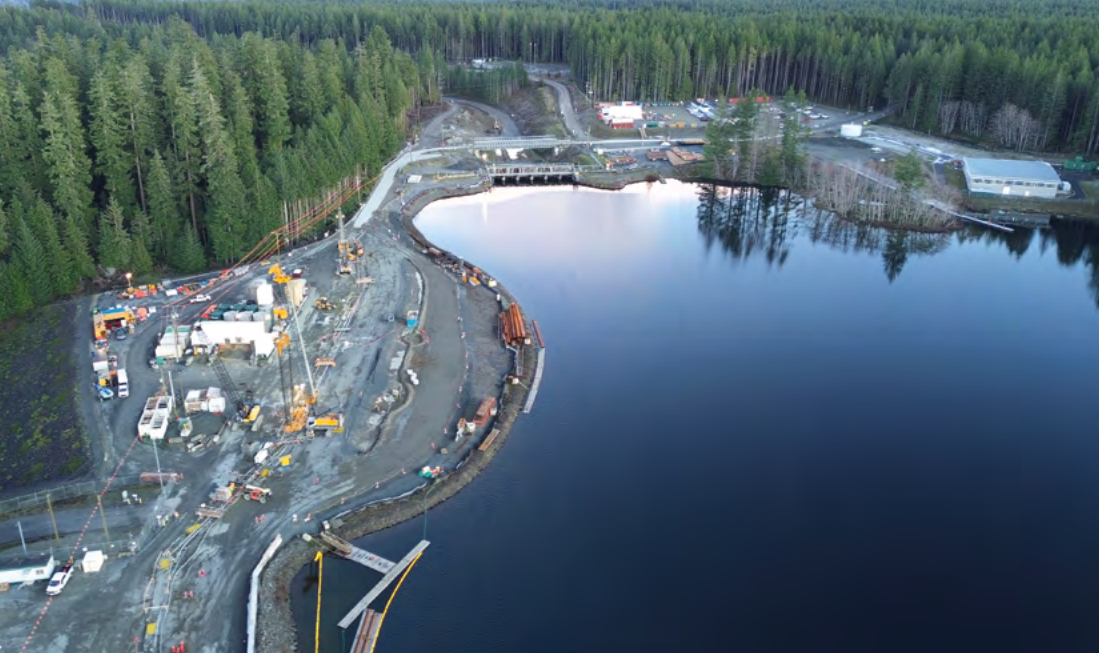
Seismische Sicherheit in Kanada: Bauer ertüchtigte den John-Hart-Damm mittels Dichtwand und Baugrundverbesserung.
