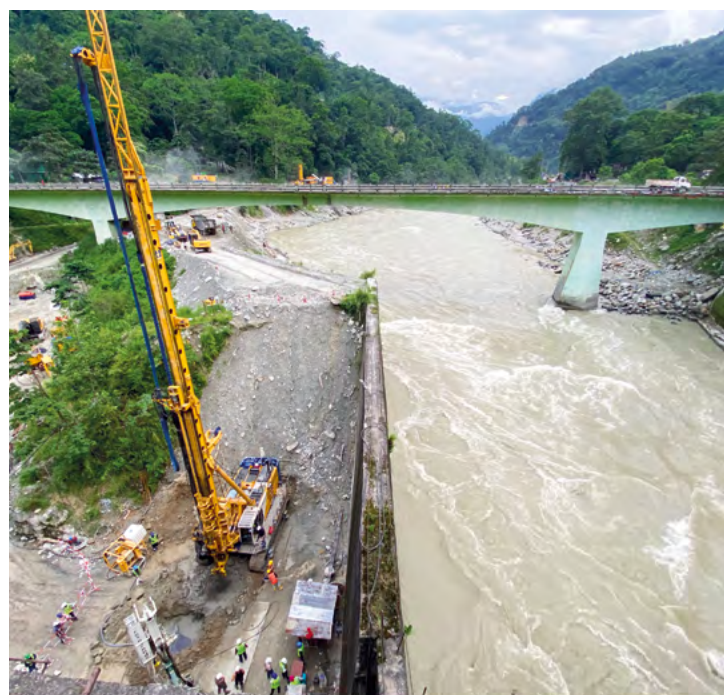
Spezialtiefbau im Himalaya: Bauer sichert die komplexen Dammstrukturen des Teesta-VI-Kraftwerks.
