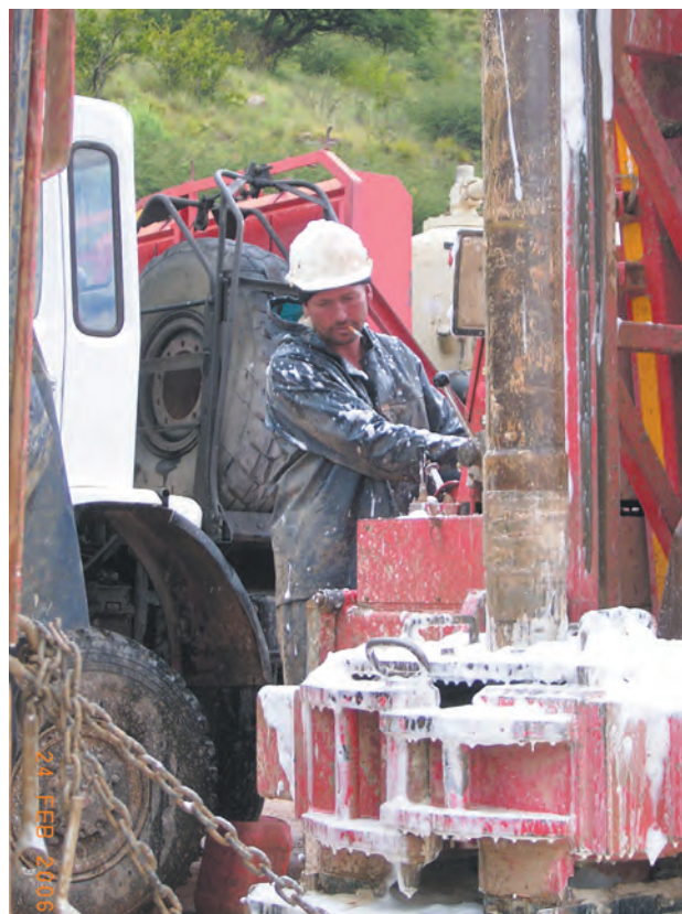
Schaumspülung für Im-Loch-Hammer Bohrungen im Festgestein
