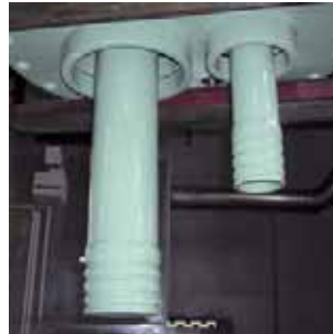
Brunnenkopfdeckelunterseite mit 2 Steigrohrdurchgängen
