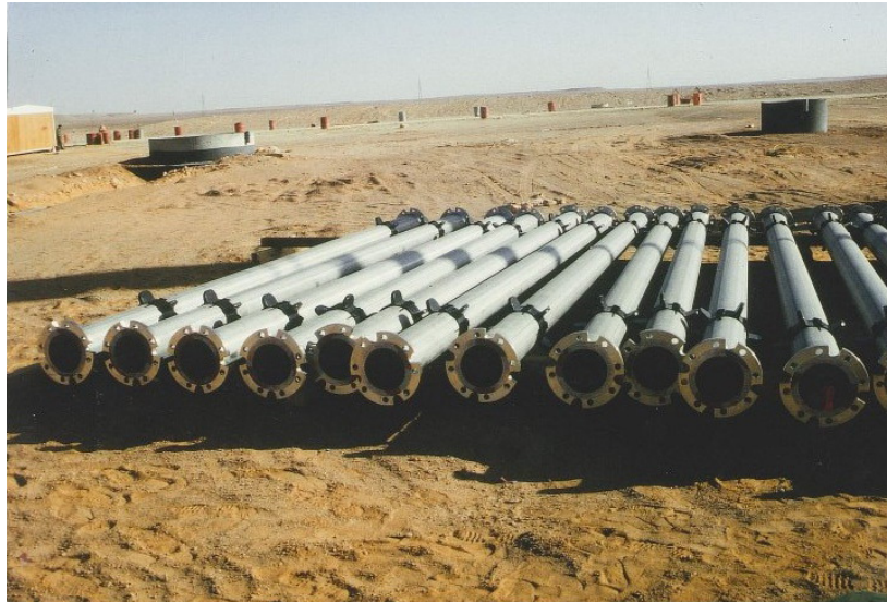
Steigrohre vor Ort
