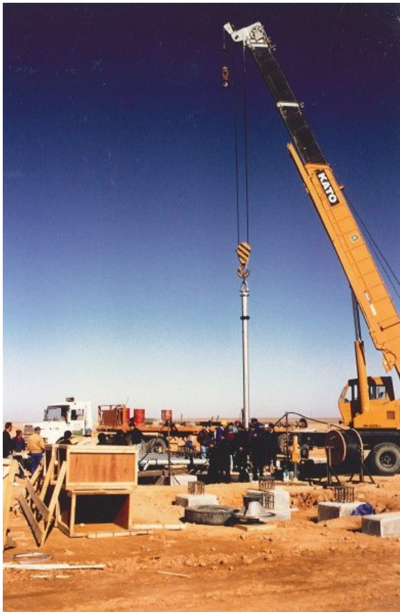
Einbau der Steigrohre vor Ort
