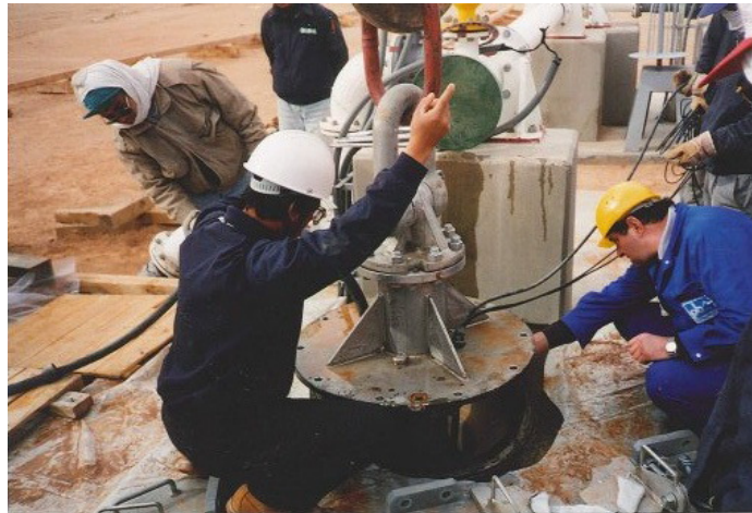
Detailansicht zum Einbau der Steigrohre vor Ort
