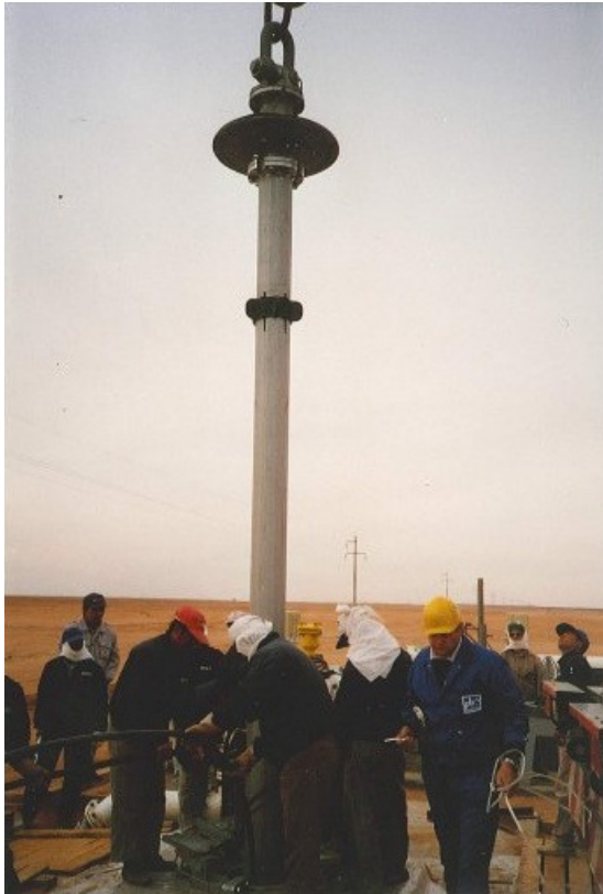
Einbau der Steigrohre vor Ort
